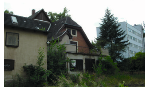
Wendorfer Weg 3 vor der Renovierung
